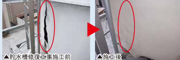
▲貯水槽修復工事施工前
