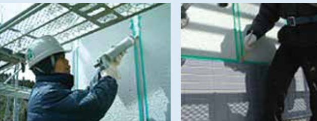
▲目地シーリング工事(施工中)
