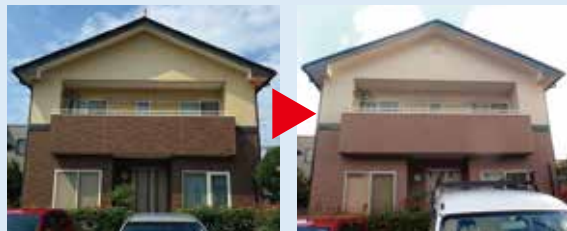
▲外壁塗装工事施工前
